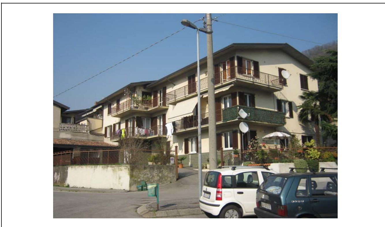
DOCUMENTAZIONE FOTOGRAFICA FRONTE panoramica di contesto
