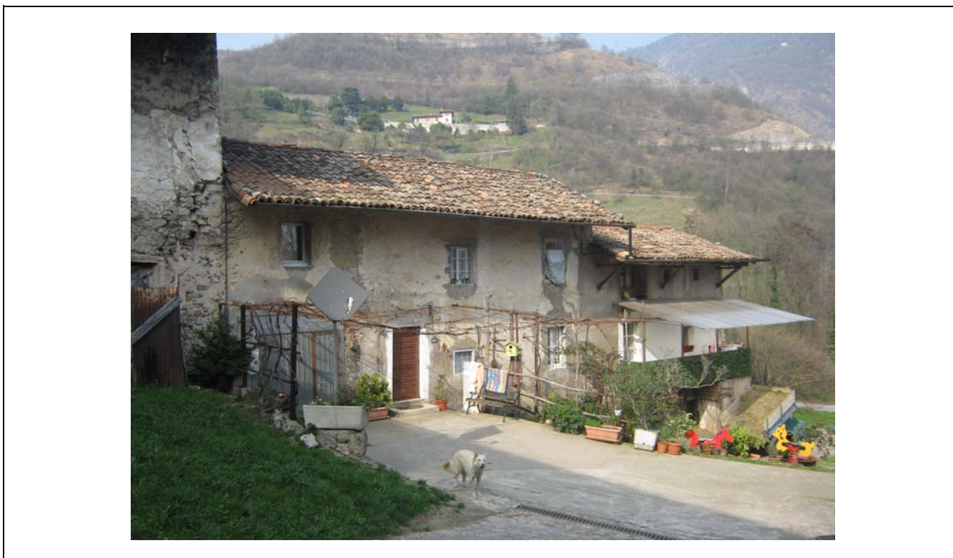
DOCUMENTAZIONE FOTOGRAFICA VISTA panoramica di contesto
