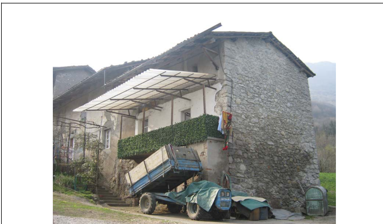
DOCUMENTAZIONE FOTOGRAFICA VISTA panoramica di contesto
