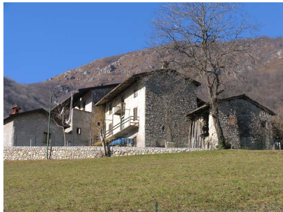
DOCUMENTAZIONE FOTOGRAFICA VISTA panoramica di contesto
