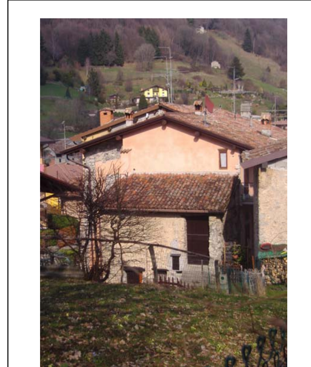
DOCUMENTAZIONE FOTOGRAFICA VISTA panoramica di contesto
