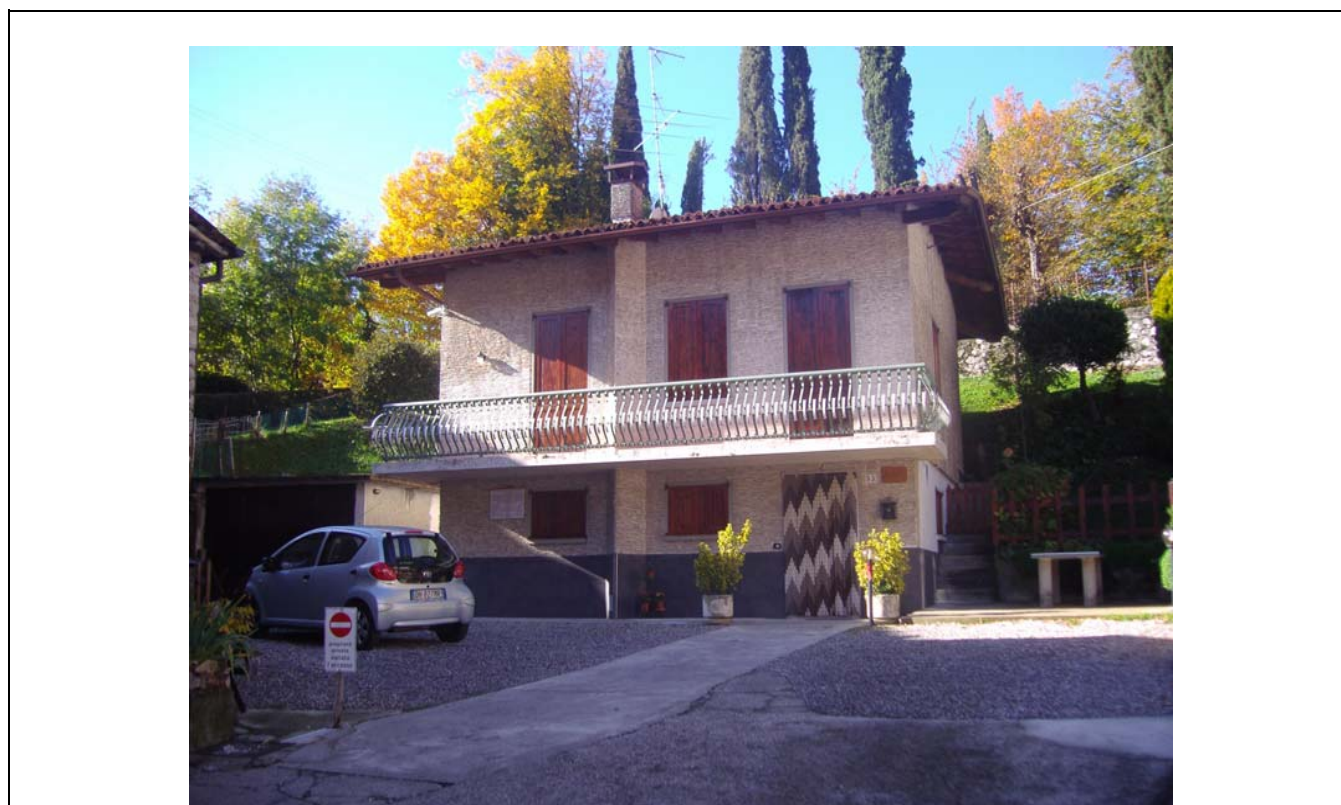
DOCUMENTAZIONE FOTOGRAFICA VISTA panoramica di contesto
