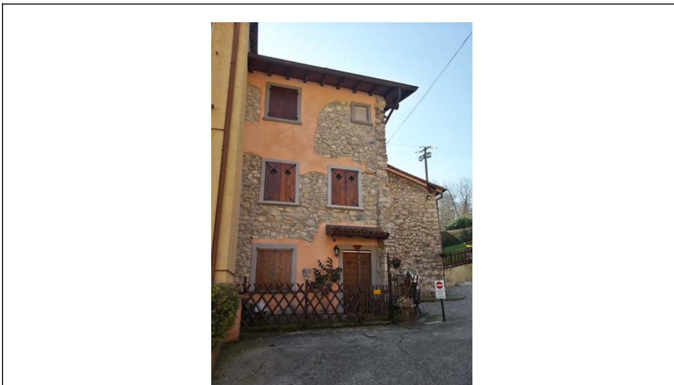
DOCUMENTAZIONE FOTOGRAFICA VISTA panoramica di contesto
