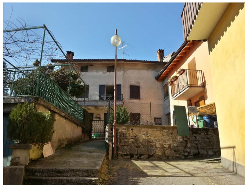
DOCUMENTAZIONE FOTOGRAFICA VISTA panoramica di contesto
