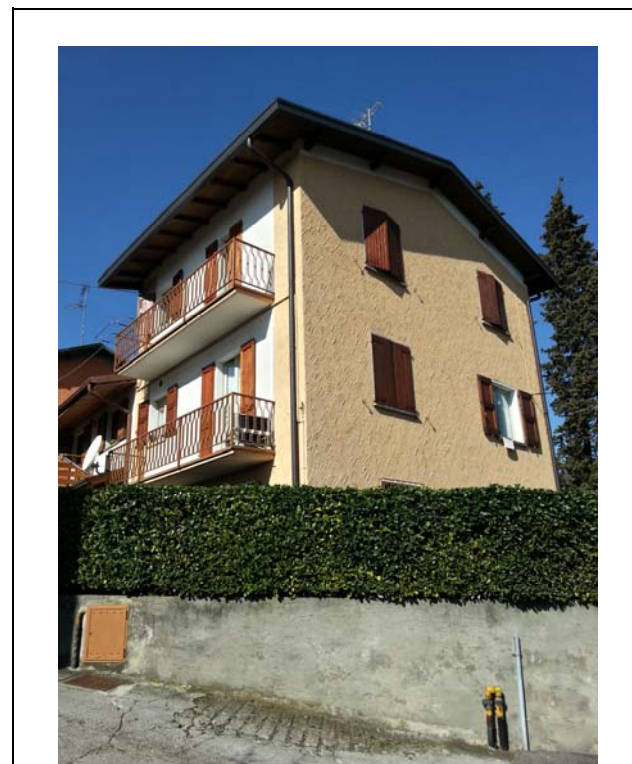
DOCUMENTAZIONE FOTOGRAFICA VISTA panoramica di contesto
