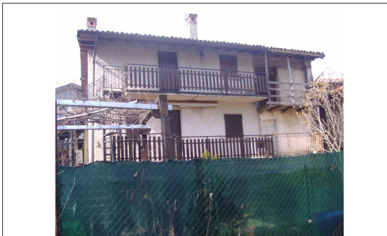
DOCUMENTAZIONE FOTOGRAFICA VISTA panoramica di contesto
