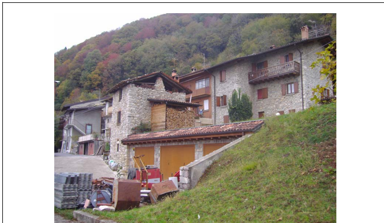
DOCUMENTAZIONE FOTOGRAFICA VISTA panoramica di contesto
