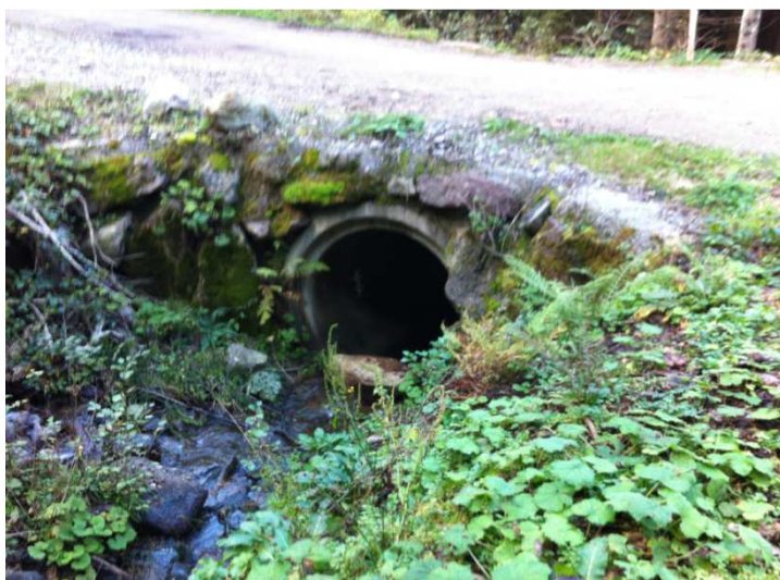
Foto 5: valle Barisole all'altezza dell' attraversamento della strada carrabile Ornica-Chiusuro-Dudello. Grazie all'ampiezza della sezione di deflusso a monte del tratto di attraversamento e alla bassa pendenza che consente la deposizione dei detriti trasportati ad oggi non si osservano condizioni di criticità.
