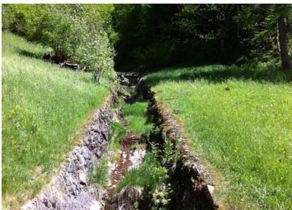
Foto 23, 24, 25 e 26: a sinistra canalizzazione in pietrame e calcestruzzo a monte dell'abitato. Il lungo tratto canalizzato è delimitato a monte da una briglia a pettine e lungo il tracciato sono stati realizzati salti di fondo per smorzare l'energia delle correnti in deflusso. Il ponticello pedonale è stato realizzato per consentire l'accesso ai proprietari dei fondi.
