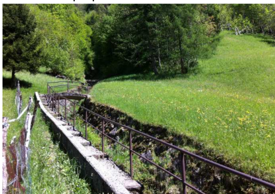
Foto 23, 24, 25 e 26: a sinistra canalizzazione in pietrame e calcestruzzo a monte dell'abitato. Il lungo tratto canalizzato è delimitato a monte da una briglia a pettine e lungo il tracciato sono stati realizzati salti di fondo per smorzare l'energia delle correnti in deflusso. Il ponticello pedonale è stato realizzato per consentire l'accesso ai proprietari dei fondi.
