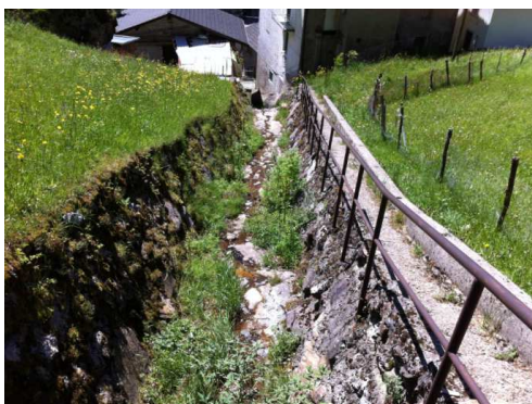
Foto 23, 24, 25 e 26: a sinistra canalizzazione in pietrame e calcestruzzo a monte dell'abitato. Il lungo tratto canalizzato è delimitato a monte da una briglia a pettine e lungo il tracciato sono stati realizzati salti di fondo per smorzare l'energia delle correnti in deflusso. Il ponticello pedonale è stato realizzato per consentire l'accesso ai proprietari dei fondi.
