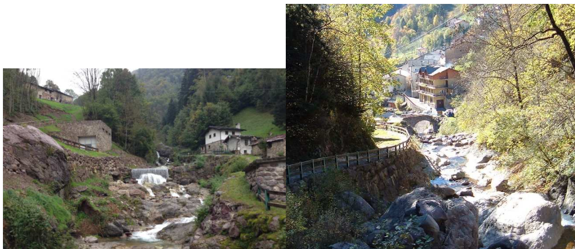
Foto 99 e 100. Località "Rasega" a monte del ponte pedonale (sponda sinistra idrografica foto a sinistra). Ripresa verso valle (foto a destra)
