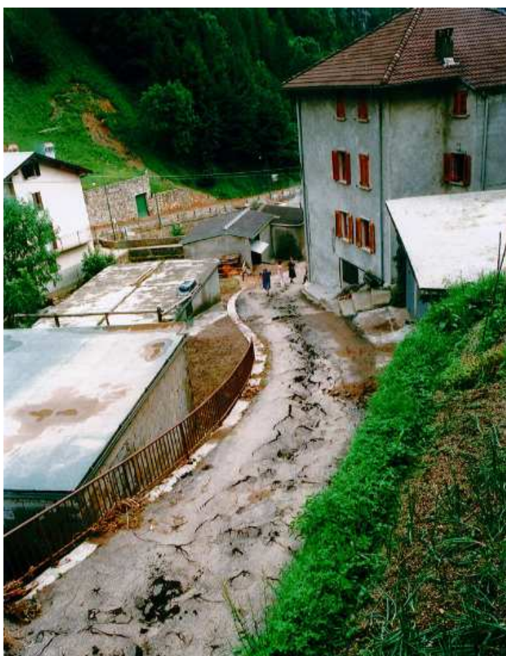
Foto 103. Sponda destra idrografica (strada carrabile) a valle del Ponte della Rasega a seguito dell'evento del luglio 1987 (per concessione di Studio Fotografico Passerini Raffaella di Piazza Brembana)
