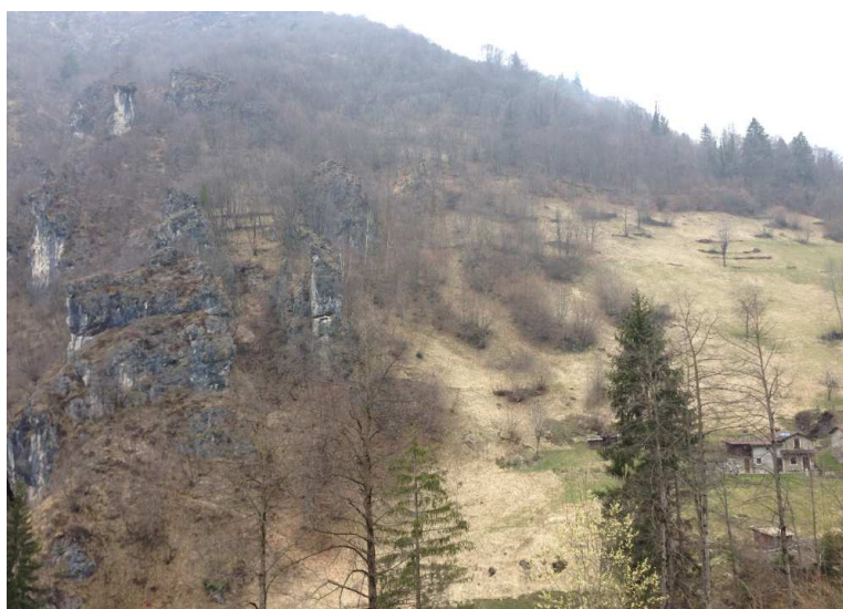
Foto 46: versante a sud del canale della "Sirta". L'area prativa è stata inserita nella sottoclasse "3V" in ragione sia della pendenza (raggiungimento di condizioni dei terreni di equilibrio limite) sia per le problematiche potenziali riscontrate a monte legate ai fenomeni di crollo
