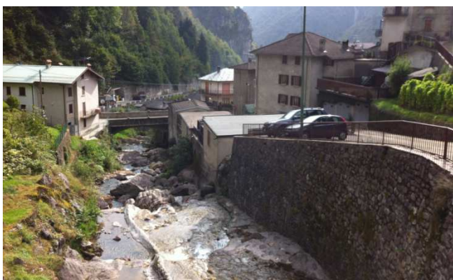
Foto 105 e 106. Ponte stradale (a sinistra) e ponte della Rasega (a destra). In caso di ostruzione del le zone coinvolte sono localizzate soprattutto lungo la sponda destra dove la strada asfaltata "convoglierebbe" le acque verso l'edificato. Nella foto a destra si osserva anche il salto di fondo a monte del ponte e il restringimento della sezione di deflusso anche legato alla presenza del fondo alveo più alto sotto l'arcata minore del ponte
