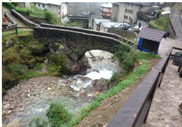
Foto 104. Danni prodotti lungo la sponda sinistra a valle del ponte della Rasega anche per l'effetto del rigurgito all'altezza del canale della Laza. Sullo sfondo il soil slip attivatosi durante l'evento ancora oggi oggetto di potenziale riattivazione nonostante le opere di consolidamento realizzate (per concessione di Studio Fotografico Passerini Raffaella di Piazza Brembana)
