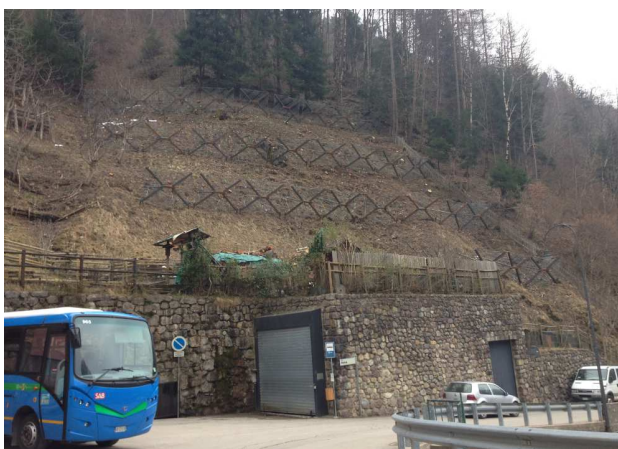
Foto 63 a sinistra: strutture fermaneve ad ombrello realizzate nel dicembre 2014 che hanno sostituito in parte le vecchie rastrelliere deteriorate (la zona e' indicata nel SIRVAL come "Roncalli"). Nel 1986 un distacco nevoso ha danneggiato un pullman
