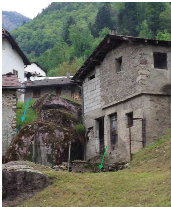
Foto 115 e 116. Località "Fusinetta" dettaglio "effetto" barriera ai deflussi fuori alveo dei fabbricati posti in sponda sinistra idrografica (foto a sinistra) e zona a valle non coinvolta nei deflussi freccia verde (foto a destra)
