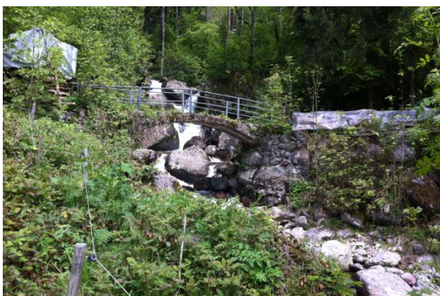
Foto 139. Ripresa verso valle dell'attraversamento pedonale
