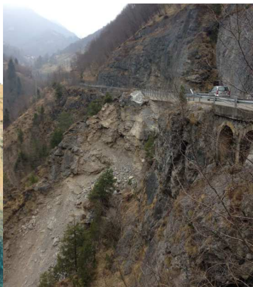
Foto 36 (anno 2009) e 37 (anno 2015): frana a valle della strada provinciale SP6-SP7 (km 48+660) per Ornica che insiste lungo il versante idrografico destro del Torrente Ornica. La frana coinvolge la formazione rocciosa della Dolomia Principale (complessivamente l'area in potenziale crollo è dell'ordine di 1000 mc) ed è stata oggetto sin dal 1990 di monitoraggio da parte della Provincia di Bergamo Settore Viabilità mediante misura dello spostamento con distometro dei perni di riscontro installati.
