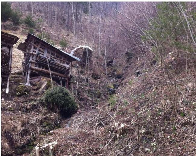
Foto 56: canale della Sirta. L'impluvio in esame si presenta asciutto per la maggior parte dell'anno, tanto che nel tratto medio terminale, nella zona prativa a sud della località "Sirta" e' individuabile solo un debole avvallamento. Percorrendo il canale verso monte si nota la presenza di detriti in alveo che possono essere trasportati a valle in caso di evento idrologico intenso
