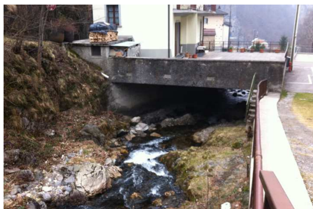
Foto 157-158. Tratto tombinato in località strada comunale per la frazione "Sirta" (ripresa panoramica a sinistra e dettaglio dell'imbocco a monte a destra)
