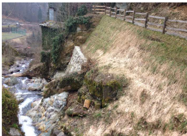
Foto 145. Opere di stabilizzazione del versante e di protezione spondale realizzate a valle del ponte pedonale in località "Cimitero"
