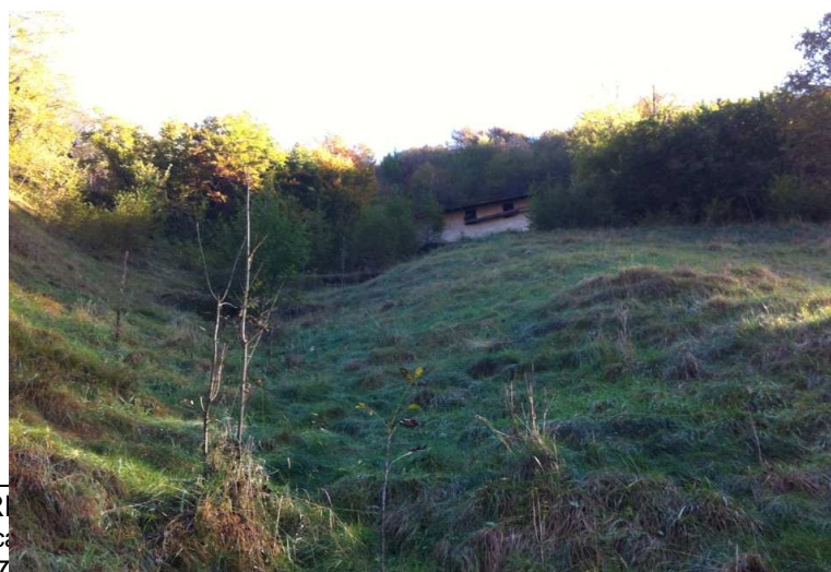
Foto 44: frana stabilizzata con opere di ingegneria naturalistica a monte delle abitazioni del ponte di imbrocco dell'abitato di Ornica (località Roncalli). Sono ancora evidenti i
