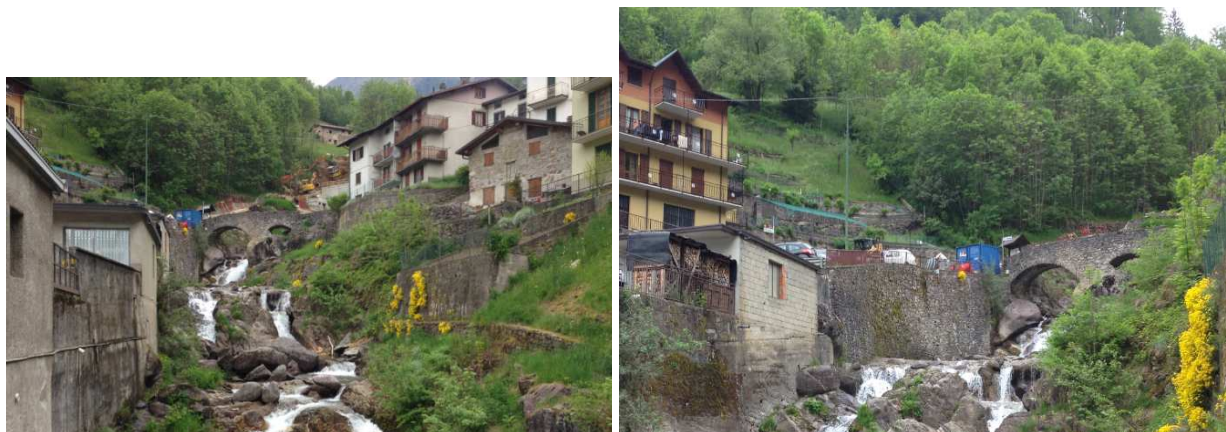
Foto 107 e 108. Località "Rasega" panoramica tratto a valle ponte pedonale (foto a sinistra), dettaglio sponda sinistra (foto a destra)
