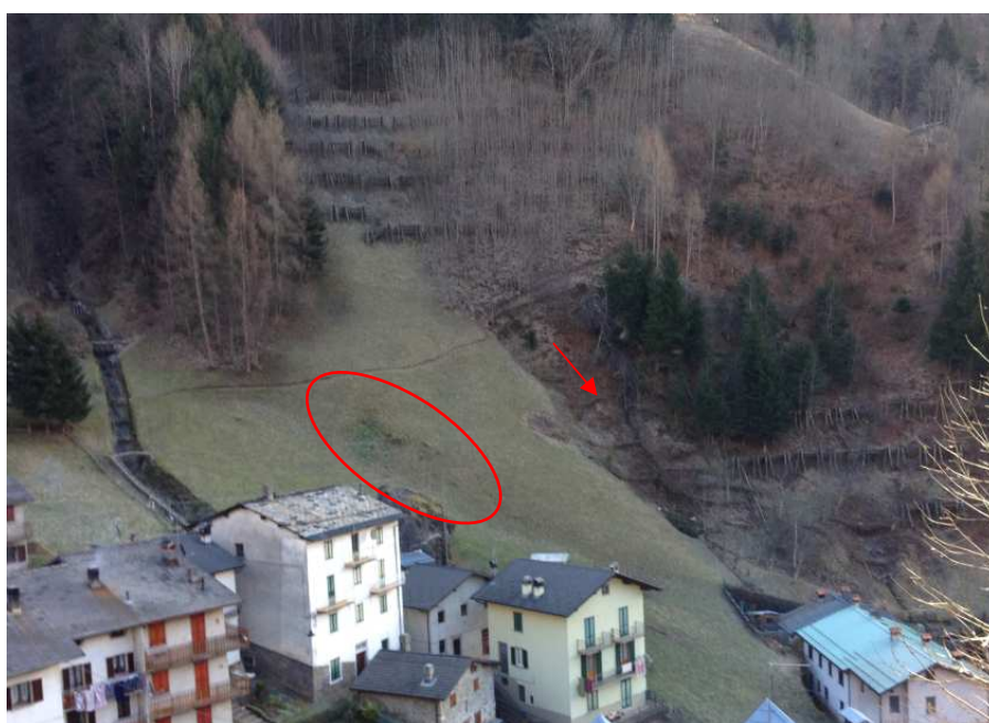
Foto 78: frana stabilizzata con viminate e palificate semplici (freccia) ma soggetta ancora a forte degradazione anche a causa delle emergenze idriche che si manifestano continuamente e ai ristagni diffusi. Nella ripresa sulla destra la "Valle della Laza" regimata dopo gli eventi alluvionali del 1987, in alto e a destra le opere fermaneve in legname. Al centro (area cerchiata) un'altra zona con presenza di terreni soggetti a ristagno idrico. La forma suggerisce anche la presenza di un "soil slip" stabilizzato.
