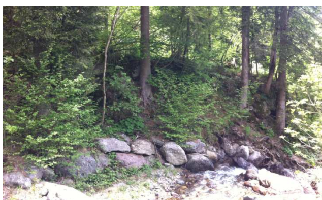
Foto 149-150. Sponde in erosione protette da scogliera in massi a secco, sponda sinistra idrografica (foto a sinistra) e in destra idrografica (foto a destra) a monte della passerella pedonale
