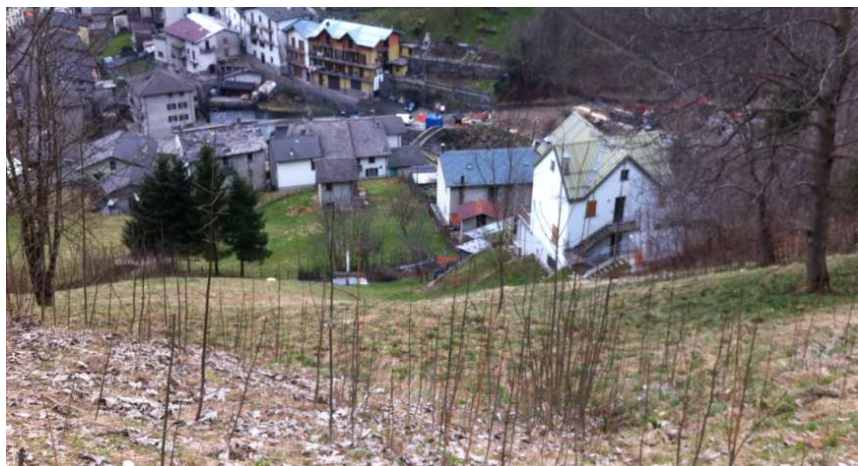
Foto 77: ripresa da monte dell'ambito di frana stabilizzata
