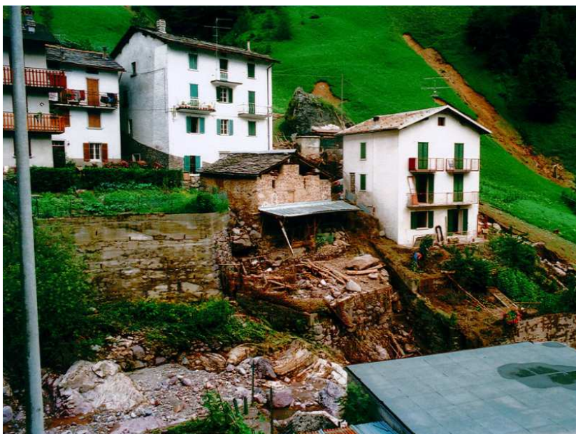
Foto 104. Danni prodotti lungo la sponda sinistra a valle del ponte della Rasega anche per l'effetto del rigurgito all'altezza del canale della Laza. Sullo sfondo il soil slip attivatosi durante l'evento ancora oggi oggetto di potenziale riattivazione nonostante le opere di consolidamento realizzate (per concessione di Studio Fotografico Passerini Raffaella di Piazza Brembana)
