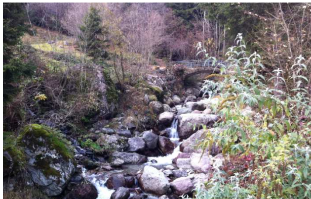
Foto 149-150. Sponde in erosione protette da scogliera in massi a secco, sponda sinistra idrografica (foto a sinistra) e in destra idrografica (foto a destra) a monte della passerella pedonale
