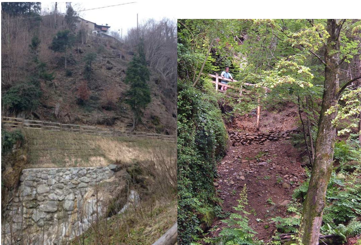
Foto 22 e 23: sentiero che collega l'abitato di Ornica al versante in destra idrografica della Valle d'Inferno (sotto la frazione "Sirta") oggetto di recente stabilizzazione della scarpata acclive in forte degradazione con terre armate e opere di difesa spondale al piede (2014, foto a sinistra). L'ambito è inserito nelle sottoclassi "4V" e "Sdg"
