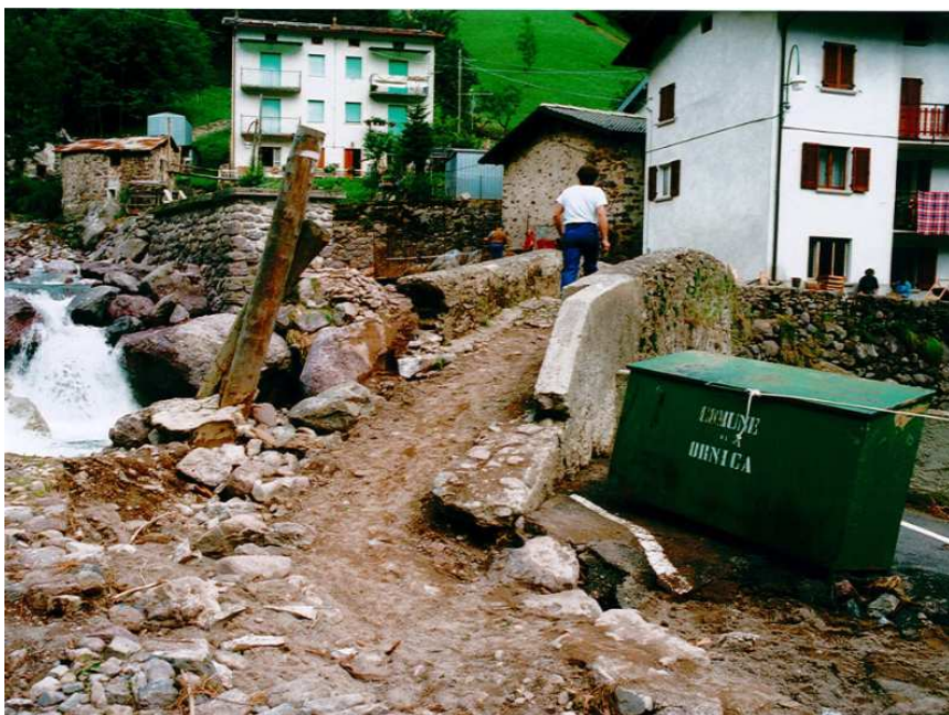
Foto 102. Sponda destra idrografica a valle del Ponte della Rasega a seguito dell'evento del luglio 1987 (per concessione di Studio Fotografico Passerini Raffaella di Piazza Brembana)
