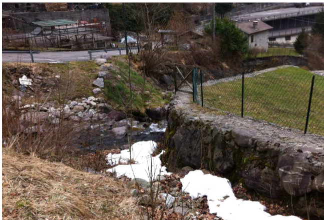
Foto 156. Canale Zucco della Bassa regimato in corrispondenza della confluenza
