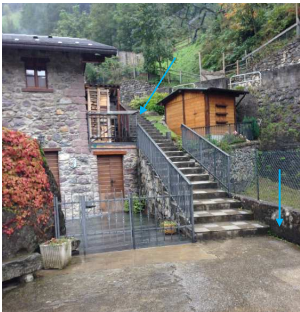
Foto 115 e 116. Località "Fusinetta" dettaglio "effetto" barriera ai deflussi fuori alveo dei fabbricati posti in sponda sinistra idrografica (foto a sinistra) e zona a valle non coinvolta nei deflussi freccia verde (foto a destra)
