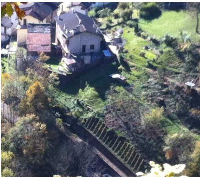
Foto 24: grate vive realizzate nel 2014 a consolidamento della scarpata in degradazione lungo la strada comunale che collega alla frazione "Sirta", poco distante dall'intervento di cui sopra
