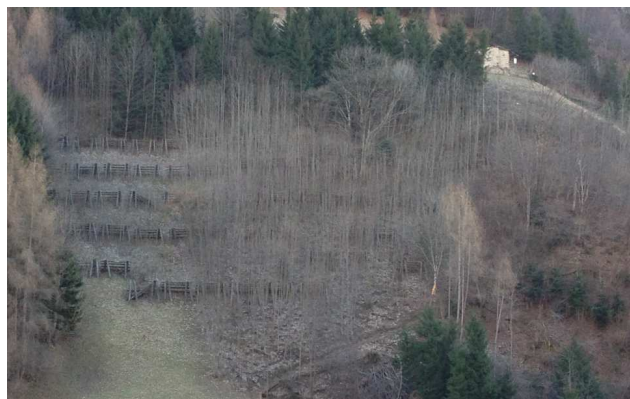
Foto 63 a sinistra: strutture fermaneve ad ombrello realizzate nel dicembre 2014 che hanno sostituito in parte le vecchie rastrelliere deteriorate (la zona e' indicata nel SIRVAL come "Roncalli"). Nel 1986 un distacco nevoso ha danneggiato un pullman
