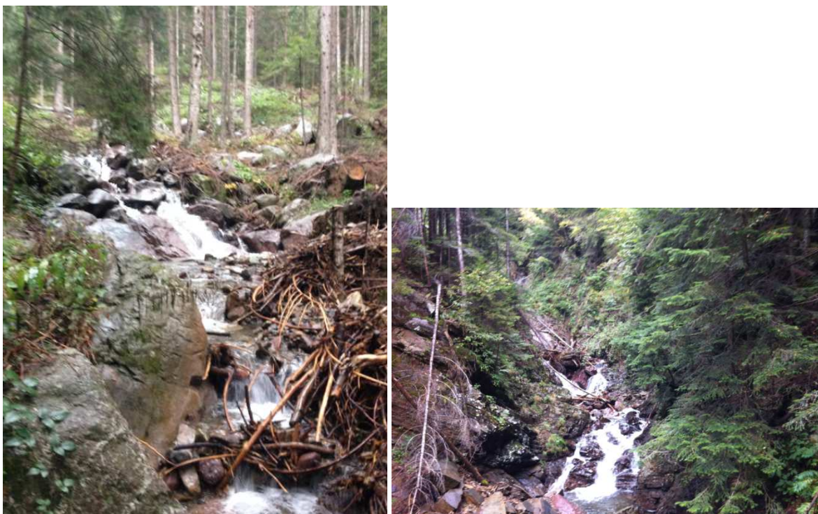
Foto 84 e 85. Valle Pianella a sinistra e Valle Salmurano a destra nella zona a monte della confluenza. La Valle di Salmurano scorre per un lungo tratto in forra rocciosa prima della confluenza con la valle Pianella
