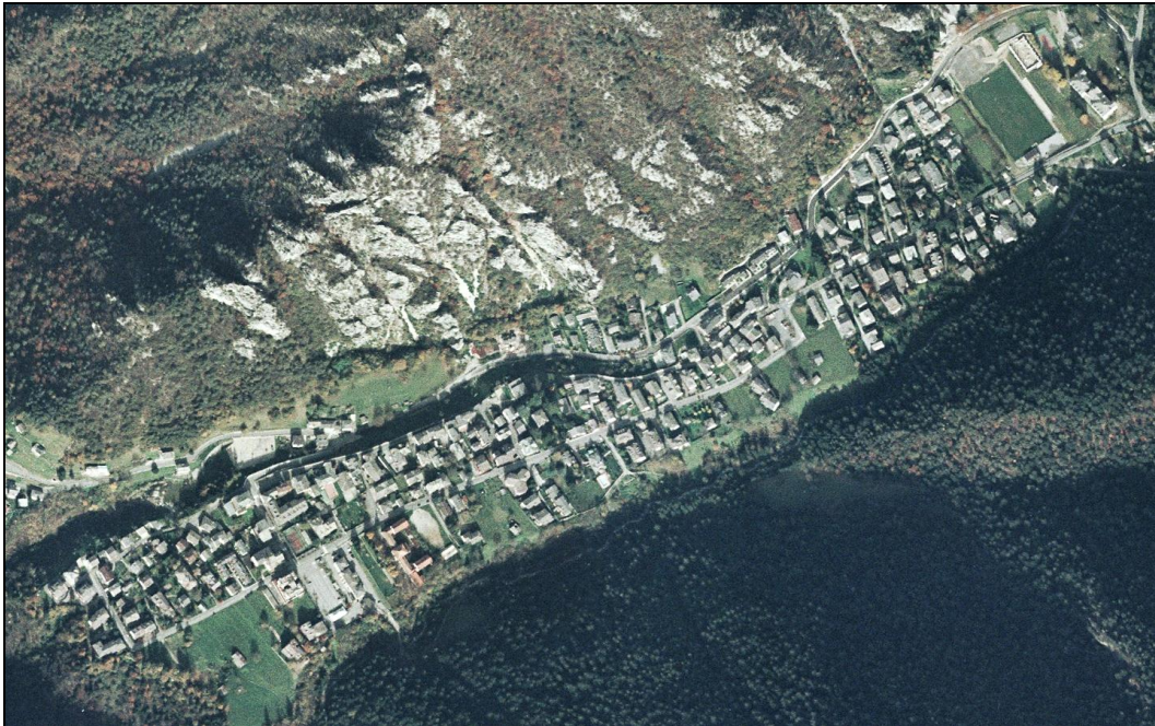
La parte "centrale" dell'abitato di Piazzatorre
