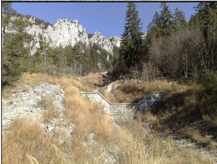
FOTO 8: briglie presenti sul collettore del conoide
