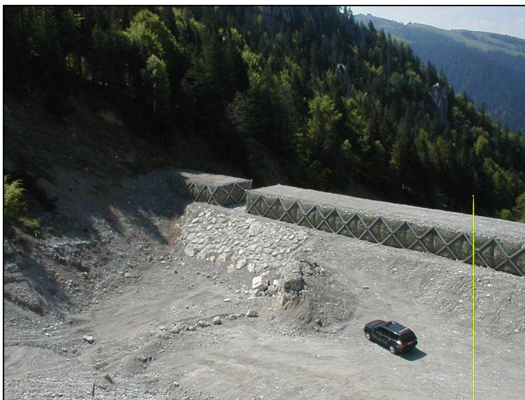
FOTO 7: vasca di espansione ripresa dall'alto
