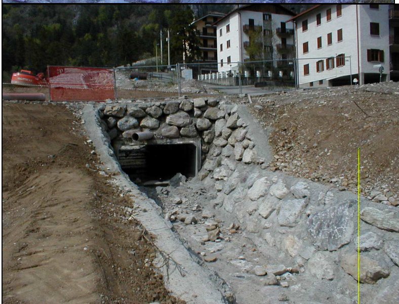
FOTO 11: sottopasso in coprem della sede stradale e tratto di canale aperto sino alla confluenza con la valle Torcola
