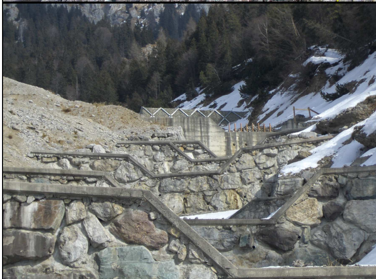
FOTO 6: briglie a valle della vasca di espansione
