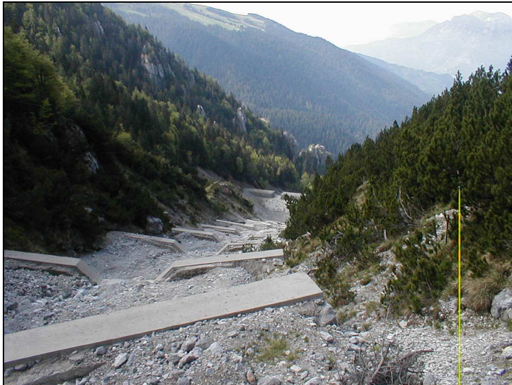
FOTO 5: briglie a monte della vasca di espansione
