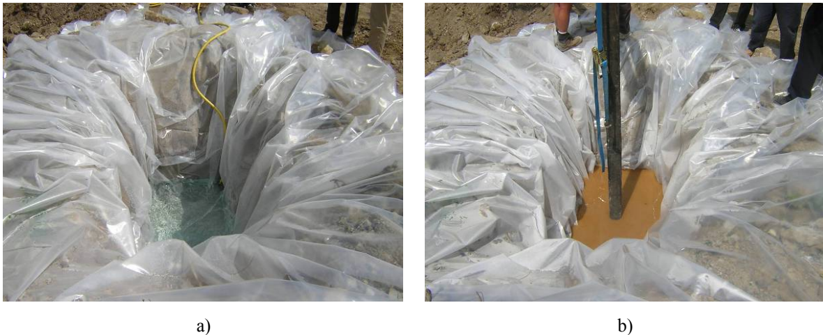
Figura 8.11 - Getto in acqua della terza miscela cementizia a) realizzata in cantiere e gettata dall'alto b) .
