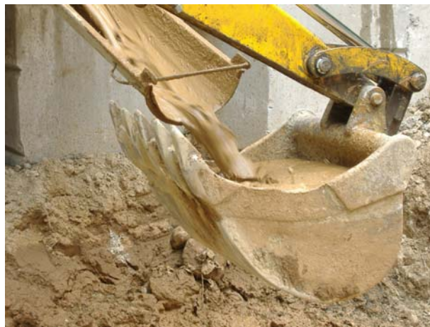
Figura 8.10 - Aspetto della miscela cementizia M3 confezionata in cantiere.
