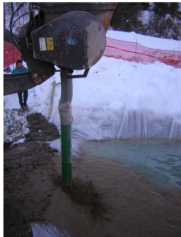
Figura 8.4 - Prova di riempimento di una trincea riempita con acqua solfatica a) impiegando la prima miscela confezionata in cantiere b) .
