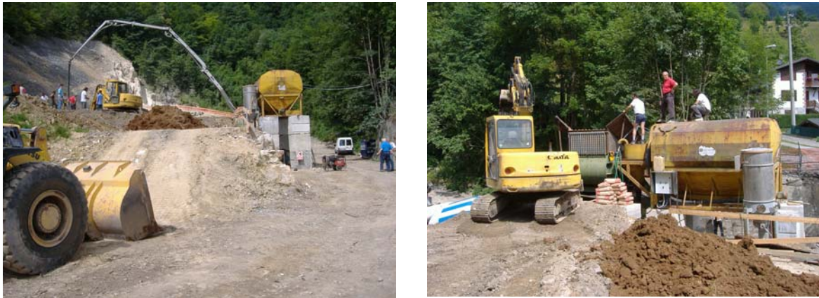
Figura 8.7 – Visione generale dell’impianto di produzione della miscela in cantiere.
