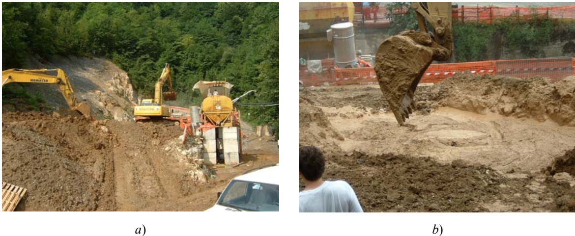
Figura 8.20 - Escavatori a) per il rimescolamento del terreno con acqua sino ad ottenerne una consistenza fluida b) .
