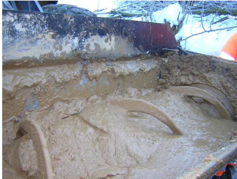
Figura 8.5 - Fluidificazione del terreno all'interno della benna.
