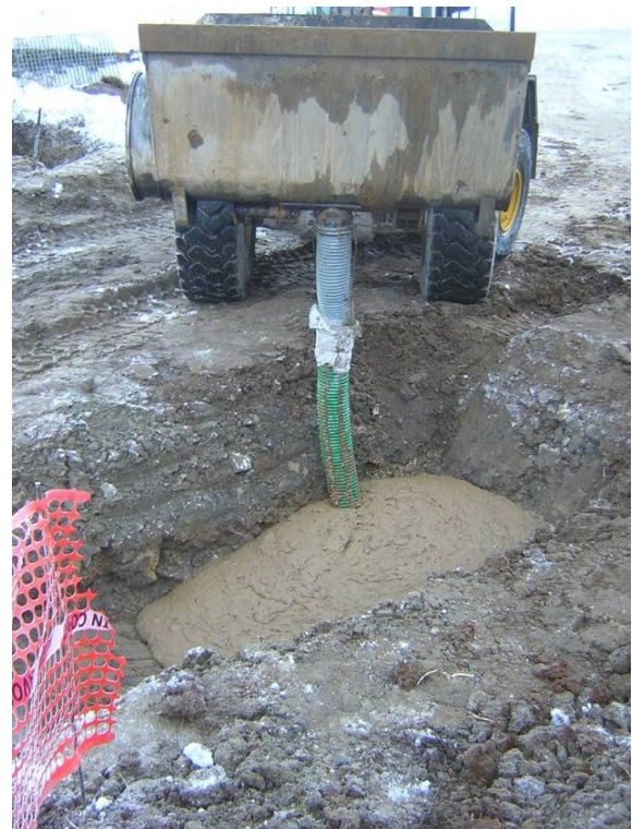
Figura 8.6 - Prova di riempimento di una trincea per verificare la mobilità della miscela.
