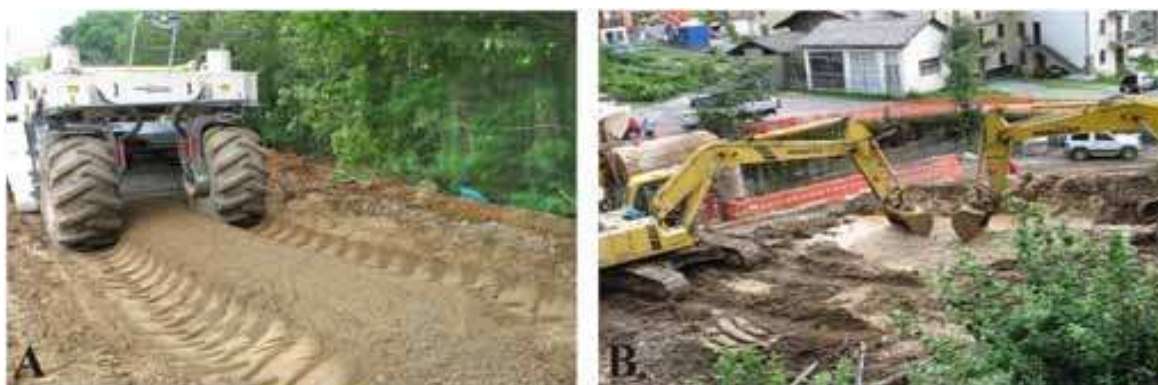
Fig. 9: Metodologie di prelaborazione a) con fresa b) vasca in terra con doppio escavatore.
