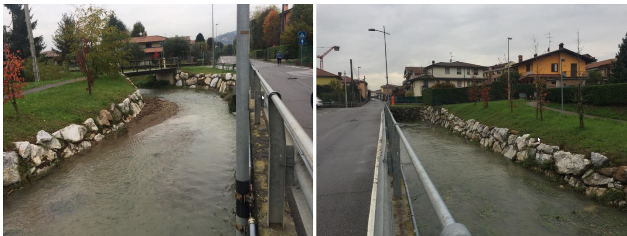
FIGURA 5 - ADEGUAMENTO DELLA SEZIONE DI DEFLUSSO DEL T. ZERRA A MONTE DELL'IMMISSIONE DEL T. VALLE D'ALBANO
