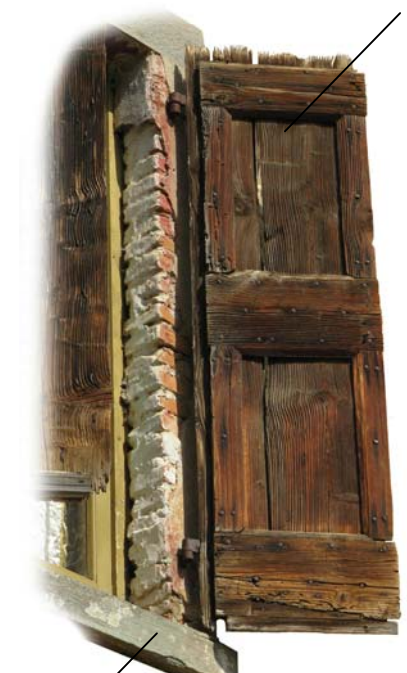
Davanzale in pietra arenaria spessore 8 cm, leggermente bocciaata
