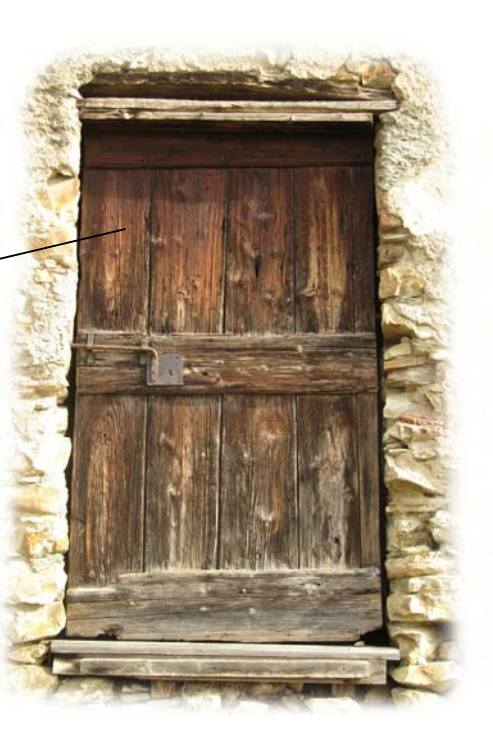
Porta in tavole verticali di larice o castagno con traversi esterni
