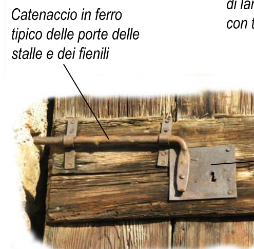
Serratura in ferro a chiave
