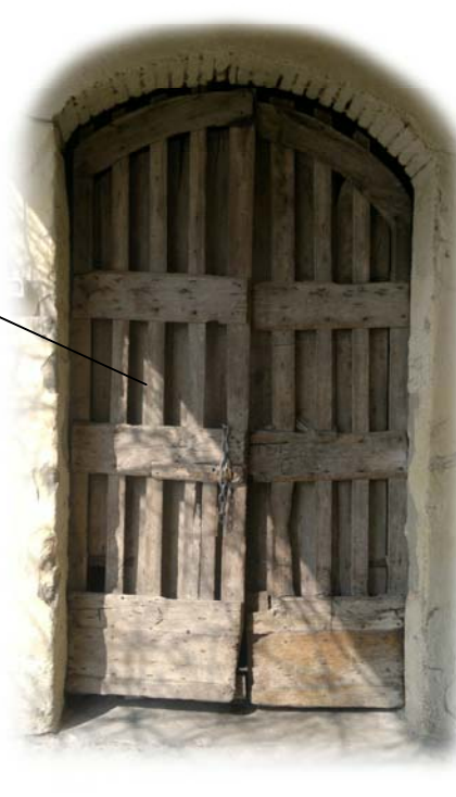
Portone a due ante con catenaccio con tavole in larice o castagno orizzontali verso l'esterno e verticali nella parte interna
