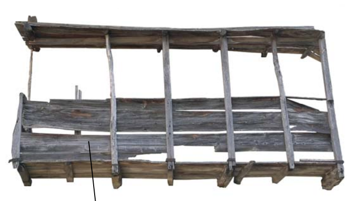
Ballatoio con parapetto pieno
