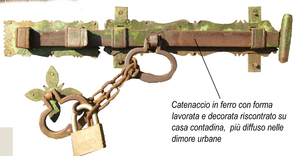
Serratura in ferro a chiave
