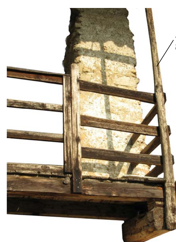
Montante agganciato ai travetti di gronda
