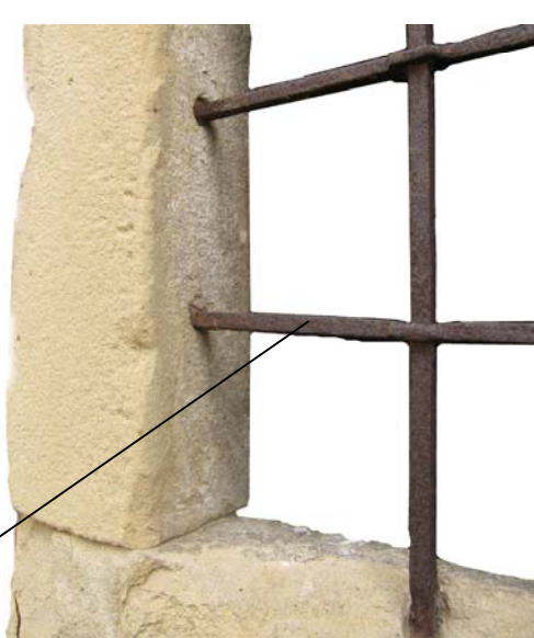
Le inferriate a sezione quadrata e tonda sono fissate nella pietra
