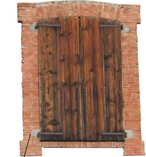
Il contorno in mattoni rossi è più utilizzato nelle case contadine in ambiti di pianura, in presenza di argilla e fornaci
