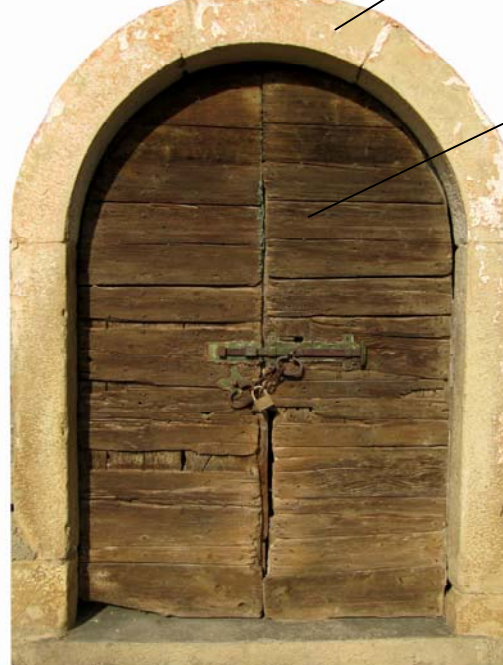
Portone a due ante con catenaccio con tavole in larice o castagno orizzontali verso l'esterno e verticali nella parte interna
