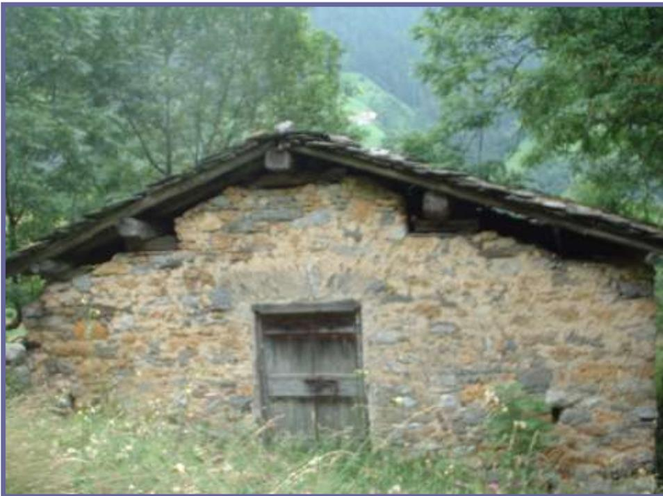
Tipologia simile alla precedente e ricorrente sul territorio, dove il timpano a travi sovrapposte e' sostituito da vuoti di muratura ricavati in corrispondenza degli appoggi delle terzere e delle travi di gronda. Anche qui con la duplice funzione di risparmio e di maggior aerazione del fienile.
