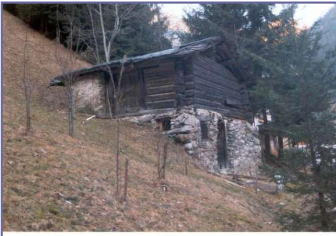
Caratteristica tipologia a “*Blockbau*”, ossia a travi sovrapposte, incrociate e connesse agli angoli con incastro a “mezzo legno”. Questa particolare struttura arriva quasi sicuramente dalla confinante Val Tartano, in Valtellina, dove e’ stato ipotizzato lo stanziamento di una colonia “walser”, proveniente dalla Valchiavenna. Tali testimonianze costruttive fanno ipotizzare che qualche famiglia “Walser” si sia all’epoca stabilita anche in Val Brembana.
