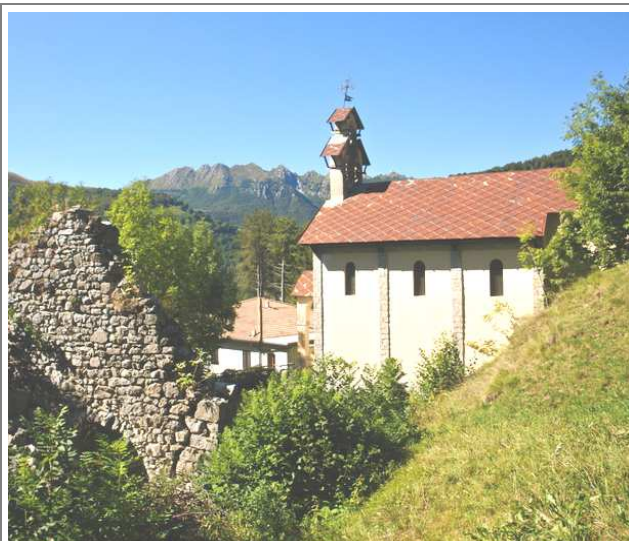
Fotografia 8: Rudere della Casa del Parroco con la Cappella dei "Morti del Contagio" (Foto web).
