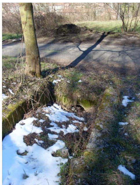
Tubature intasate lungo la Stradella della Vidalba
